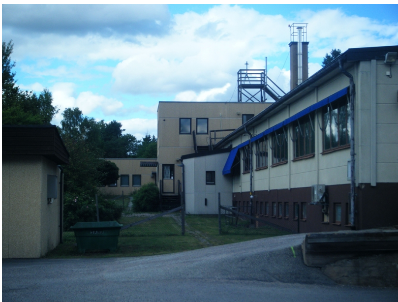
Figur 28. Industribyggnaden på Bromsen 11 innan ny exploatering.
